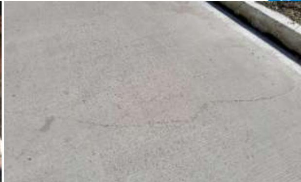
Sector comprendido en la carrera 14 entre calles 8 A y 14: en los bordillos se evidencian algunos tramos en mal estado y problemas de filtraciones entre éstos y las placas de pavimento y en algunos sectores se ve interrumpida la construcción de los andenes.
