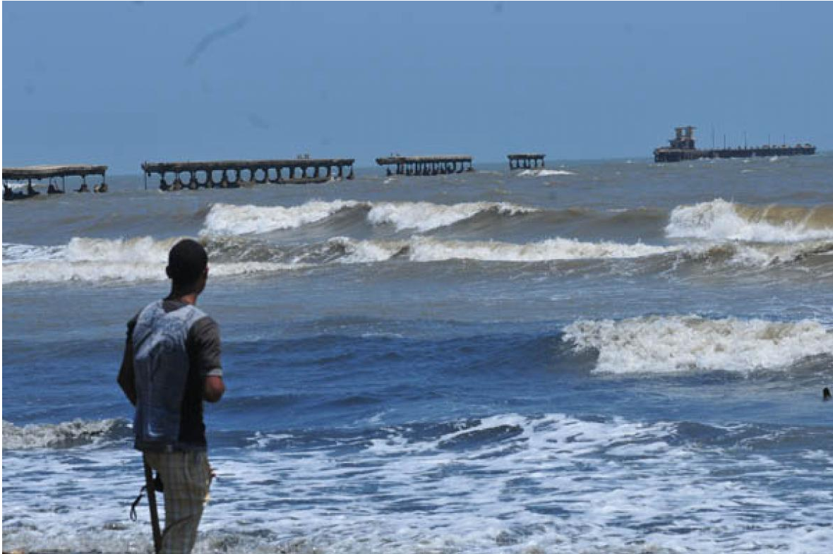
Muelle de puerto Colombia.
