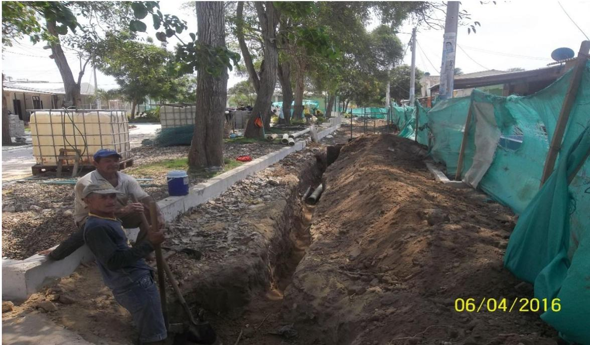
Tubería de alcantarillado que se esta reemplazando.
