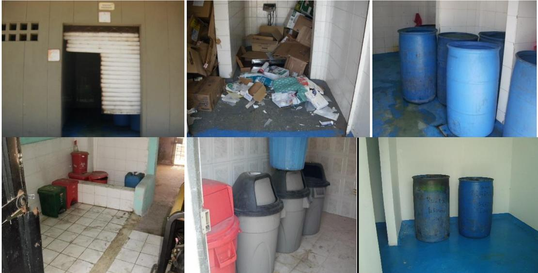
Los sitios de Disposición Central de Residuos, son diseñados con cierre hermético, pisos lisos para el fácil lavado, zócalos en mediacaña.
