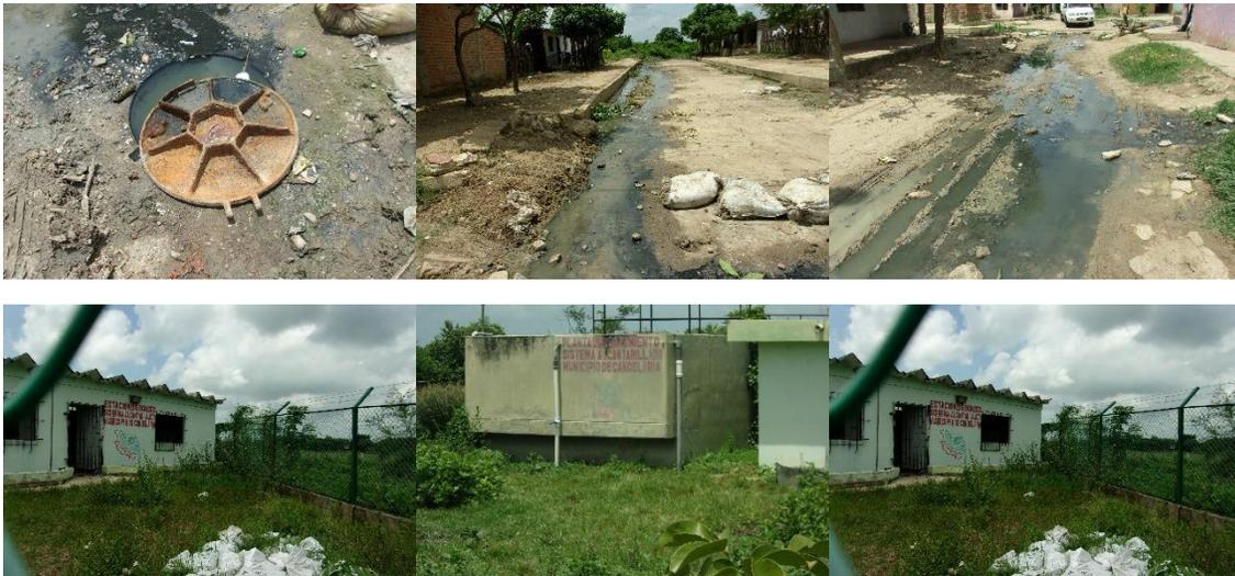
**REGISTRO REBOSADO CON TAPA EN CALLE 8 CARRERA 15 – AGUAS SERVIDAS PUTREFACTAS EN VIA – CORRIENTE CERCA A PLANTA DE TRATAMIENTO – INSTALACIONES SIN FUNCIONAMIENTO DE PLANTA DE TRATAMIENTO SOLO RECIBE LAS AGUAS SERVIDAS DE LA POBLACION DE DONDE SON ENVIADAS AL ARROYO FLECHA**
